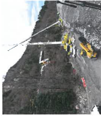
Déraillement du train des Pignes suite à une chute de blocs transperçant les filets de protection - 2 morts (2014)
